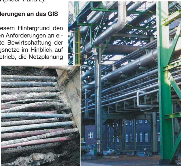
Bild 1 (links): Erdverlegte, dreilagige Kabeltrasse Bild 2 (rechts): Große Rohrbrücke
